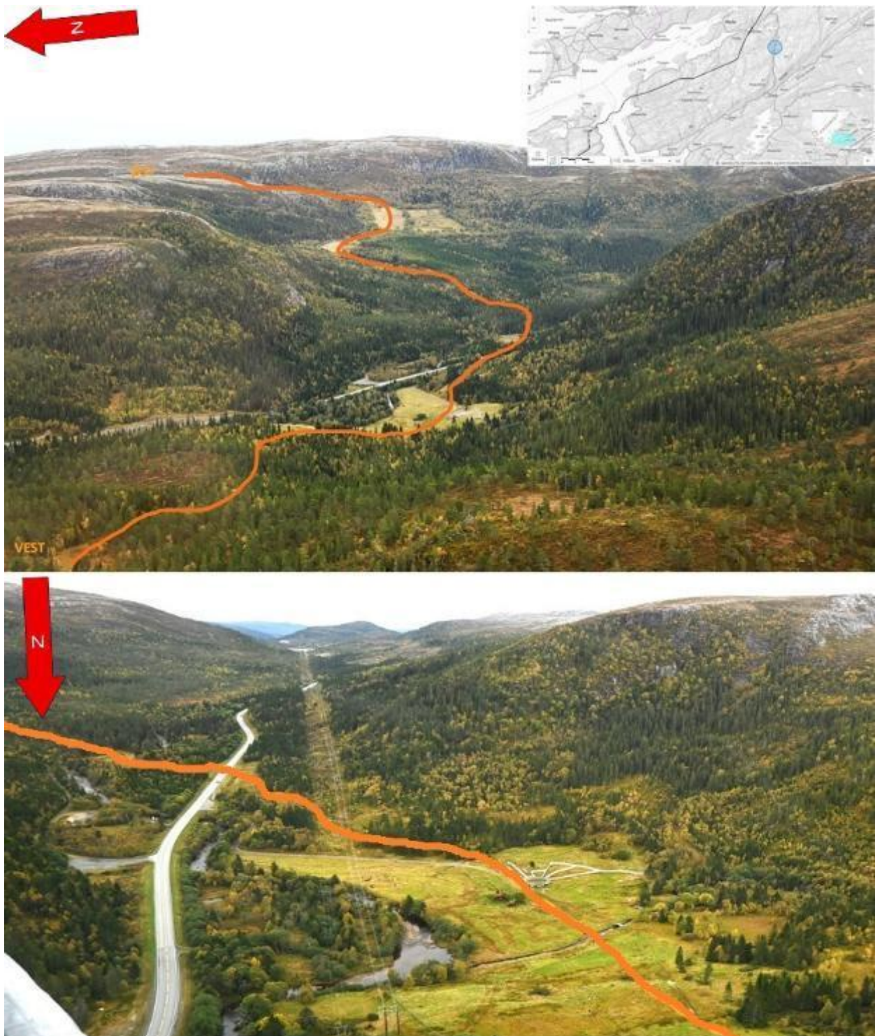
Figur 44. Flyttleia som krysser Haugsdalen sett fra to posisjoner. Merk gjerdeanlegget i det nederste bildet (Befaringsbilder MØN/LA).
