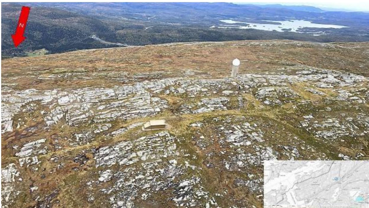
Figur 40. Olsøyheia radarstasjon (Befaringsbilde MØN/LAJ).
