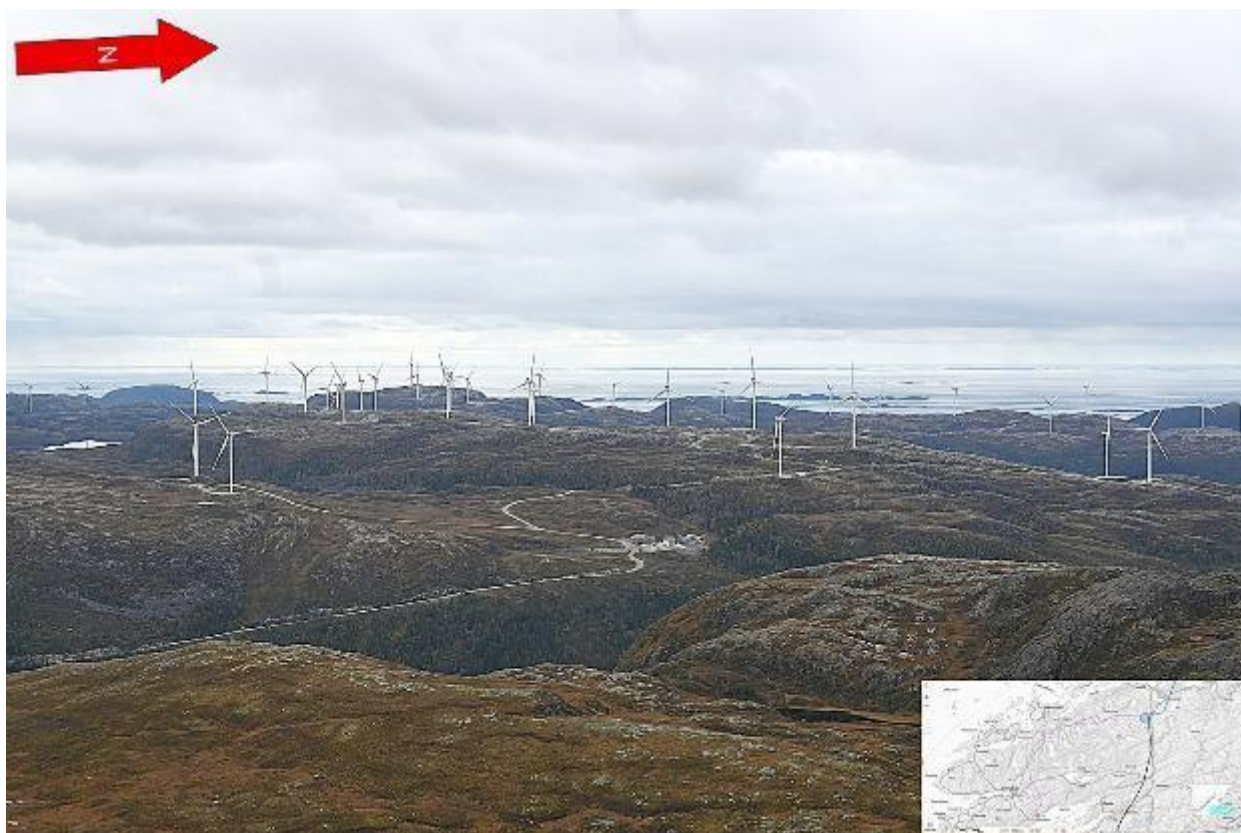
Figur 60. Storheiaplatået med anleggene sett fra sør (Befaringsbilde MØN/LAJ).
