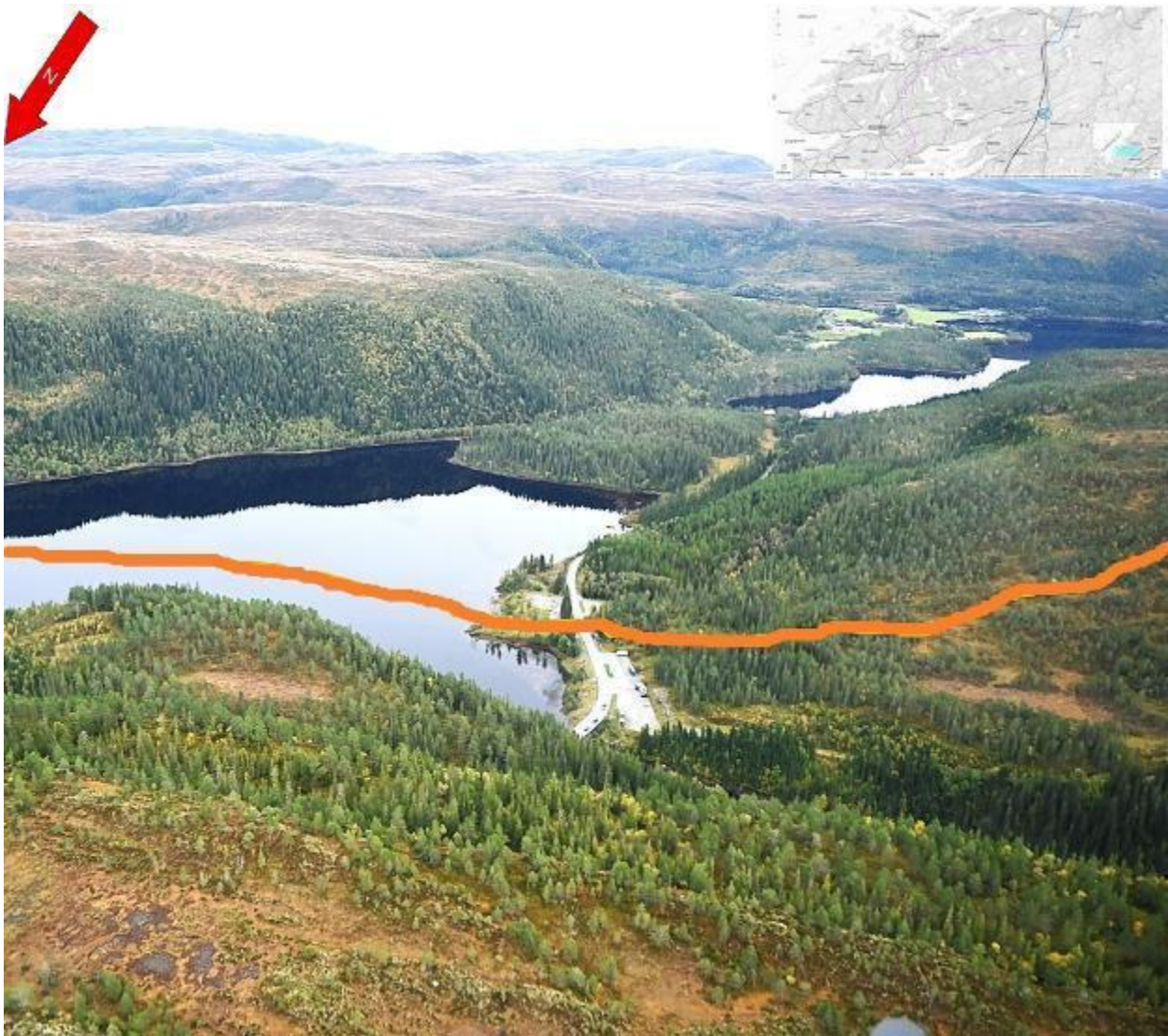
Figur 63. Stengt flyttlei over Krinsvatnet (Befaringsbilde MØN/LAJ).
